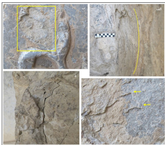
شکل ۶. الف- انحناى ديواره شمال شرقى تاق بزرگ که در اثر چرخه‌های متناوب یخ‌زدگی - ذوب ایجاد شده است؛ ب- بخش‌های منفصل‌شده نقوش برجسته در اثر چرخه‌های یخ‌زدگی؛ ج- پوسته‌شدگی سطح تحتانی ضلع غربی تاق بزرگ در اثر یخ‌زدگی؛ د- بزرگنمایی ترک‌ها و انفصال‌های ایجادشده در اثر پدیده یخ‌زدگی بالای کلاه‌خود خسرو پرویز.
