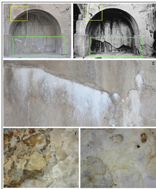
شکل ۱۰. الف- تصویر تاق کوچک (توسط هیئت ژاپنی در سال ۱۳۴۴)؛ ب- تصویر در سال ۱۳۹۸ که بخش‌های مرمت‌شده و شوره محل اتصال در آن مشخص است؛ ج- بازتبلور نمک‌های محلول در تاق کوچک که از محل اتصال سنگ‌های جایگزین بیرون زده است؛ د- بزرگنمایی X۵۰ از سطح سفید در تاق کوچک؛ و- بزرگنمایی محل تلاقی نمک‌ها و سطح اصلی که
