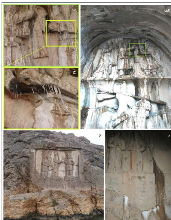
شکل ۶. الف- انحناى ديواره شمال شرقى تاق بزرگ که در اثر چرخه‌های متناوب یخ‌زدگی - ذوب ایجاد شده است؛ ب- بخش‌های منفصل‌شده نقوش برجسته در اثر چرخه‌های یخ‌زدگی؛ ج- پوسته‌شدگی سطح تحتانی ضلع غربی تاق بزرگ در اثر یخ‌زدگی؛ د- بزرگنمایی ترک‌ها و انفصال‌های ایجادشده در اثر پدیده یخ‌زدگی بالای کلاه‌خود خسرو پرویز.
